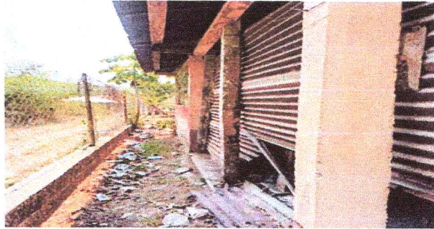
Foto 4: sustitución de soporte de madera por metal.
