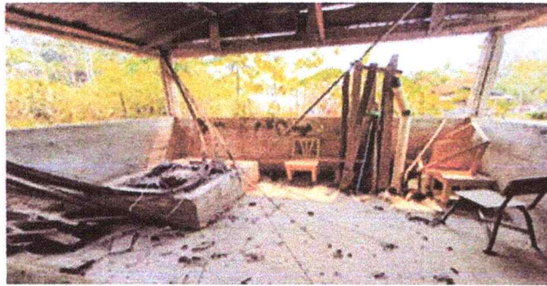
Foto 3: sustitucion de piso de torta de concreto
