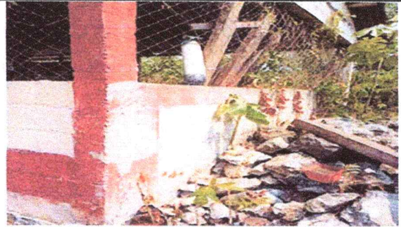
Foto 2: reparacion de cuneta de concreto.
